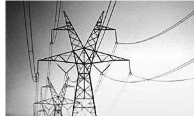
Fig. 2.9. Firele din aluminiu sînt ușoare și au o conductibilitate electrică înaltă.
