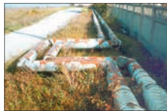
3.16. Buclă compensatoare a rețelei termice
